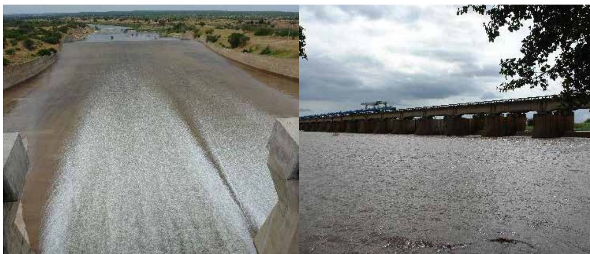
Presa Massingir sobre el río Olifants (izquierda). Dique Macarretane sobre el cauce principal del río Limpopo (derecha) (Vogel 2010).
