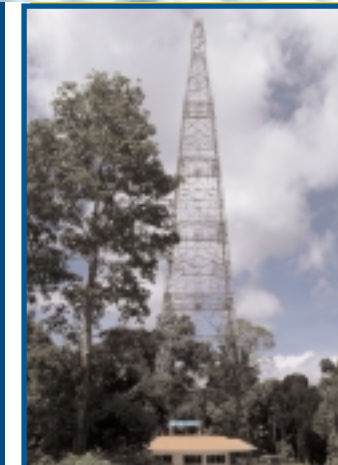
La tour d'échantillonnage de 100 m de haut dont est dotée la nouvelle station de la VAG dans la vallée de Danum
